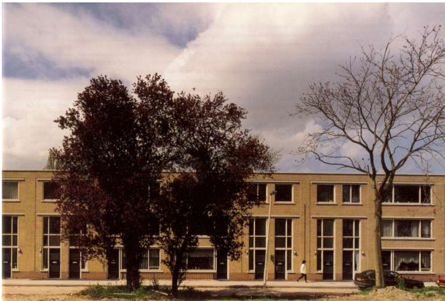
Gevel/facade Likhorst. Foto Maurice Brandts
